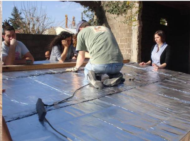
Luego colocamos **membrana asfáltica** soldándola con pistola de calor, sin adherirla a la superficie (simplemente apoyada) teniendo en cuenta que ambos materiales trabajan de distinta manera. La principal función de la membrana es la de componente impermeable del techo.
