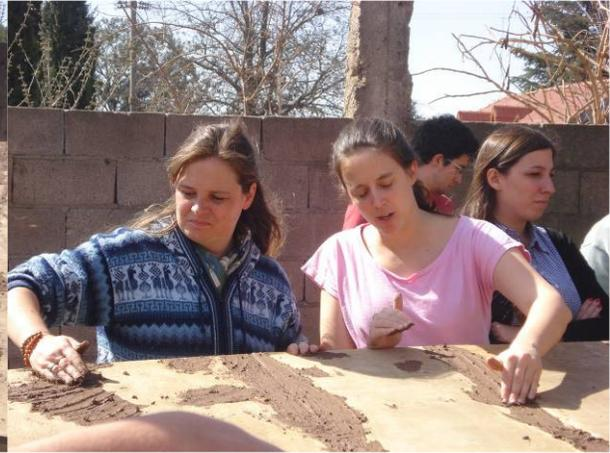
En primer lugar se pasó **barro** formado con tierra arcillosa para emparejar las uniones de los fenólicos y eliminar las irregularidades de la superficie. Una vez que secado pasamos un taco de madera raspando para eliminar restos de barro.
