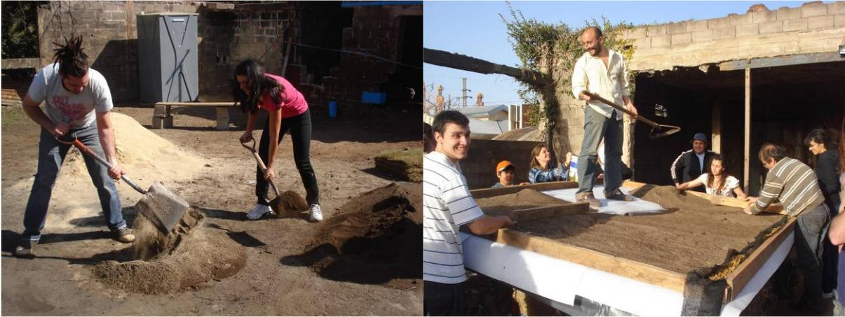
Luego se mezcló en seco **tierra orgánica** con **arena** en partes iguales y se desparramó sobre la superficie con una altura de 5cm. Este es el **sustrato** de crecimiento de las especies vegetales. La arena le da suficiente aire al sustrato para que el agua pueda escurrir una vez que haya utilizado la que demande la vegetación.
