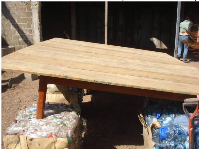
La misma estaba armada con una estructura de unas viejas mesas cuyas patas fueron cortadas de manera de generar una pendiente del 15% y apoyadas sobre unos bloques de botellas plásticas prensadas que se habían experimentado en otra ocasión. Sobre la estructura apoyaban tablas de **fenólico** que los integrantes de Proyecto Mascaró habían conseguido de reciclaje.
