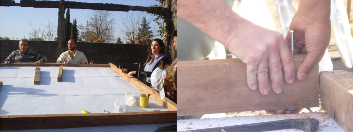
Sobre el perímetro se colocaron **tablas de madera de 2"x3"**, atornilladas a la tarima con tornillos y arandelas de goma para que al atravesar la membrana y el nylon y al apretar mantengan bien sellado el paso. Bajo la tabla que va en el lado donde escurre el agua del techo se colocan arandelas de goma un poco más altas para facilitar el escurrimiento.
