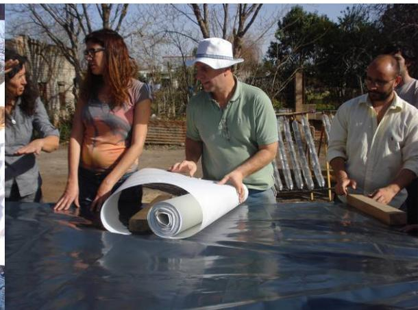
Sobre la membrana colocamos un **nylon de 200 micrones**, que colabora con la aislación hidrófuga y junto con el **geotextil** impiden que las raíces de la vegetación puedan atravesar la membrana. En caso de tener que superponer el nylon porque la superficie a cubrir sea mayor, el Arq. recomendó un solape no menor a 50cm.
